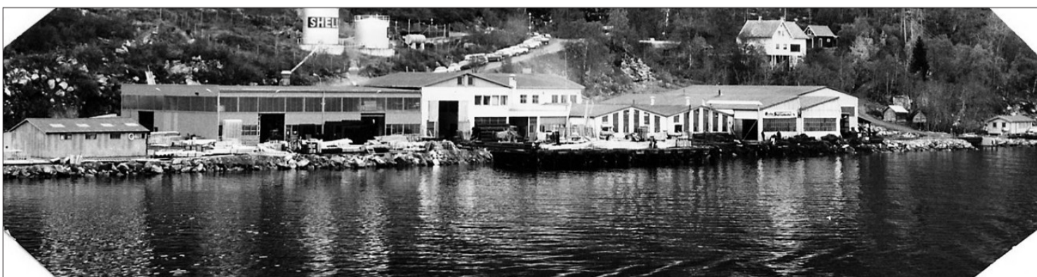
Pengar frå salet av Ørsta Stålindustri gav grunnlaget. (Anlegget i Skorgeura i 1974).
